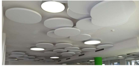
Rundleuchten mit Akustikseglern
