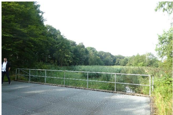
Foto 13: Einleitungsstelle des vorhandenen RRB im Osten mit ...
