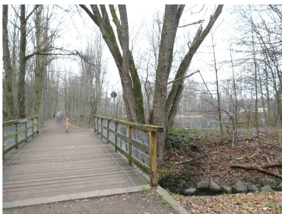
Foto 23: Brücke westlich der geplanten Einleitungsstelle
