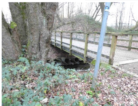
Foto 24: Blick von Norden auf Brückenbauwerk mit darunterliegenden Einleitungen ...
