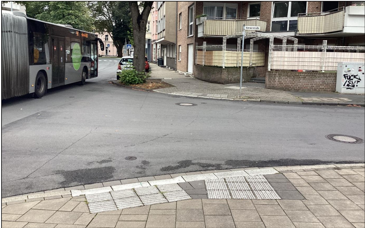
Abbildung 32: Querung mit taktilen Elementen über die Körnerstraße; Quelle: eigene Aufnahme
