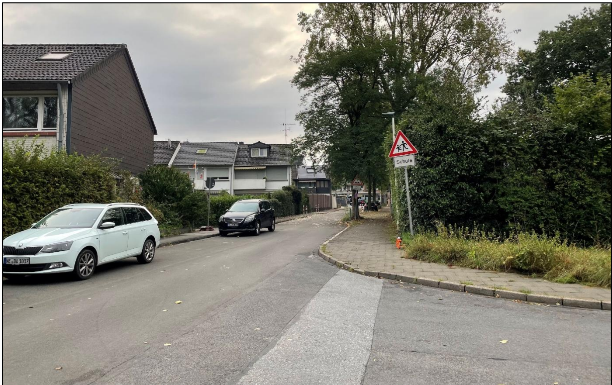
Abbildung 19: Fehlende Bordsteinabsenkung im Einmündungsbereich zur Wilbergstraße; Quelle: eigene Aufnahme
