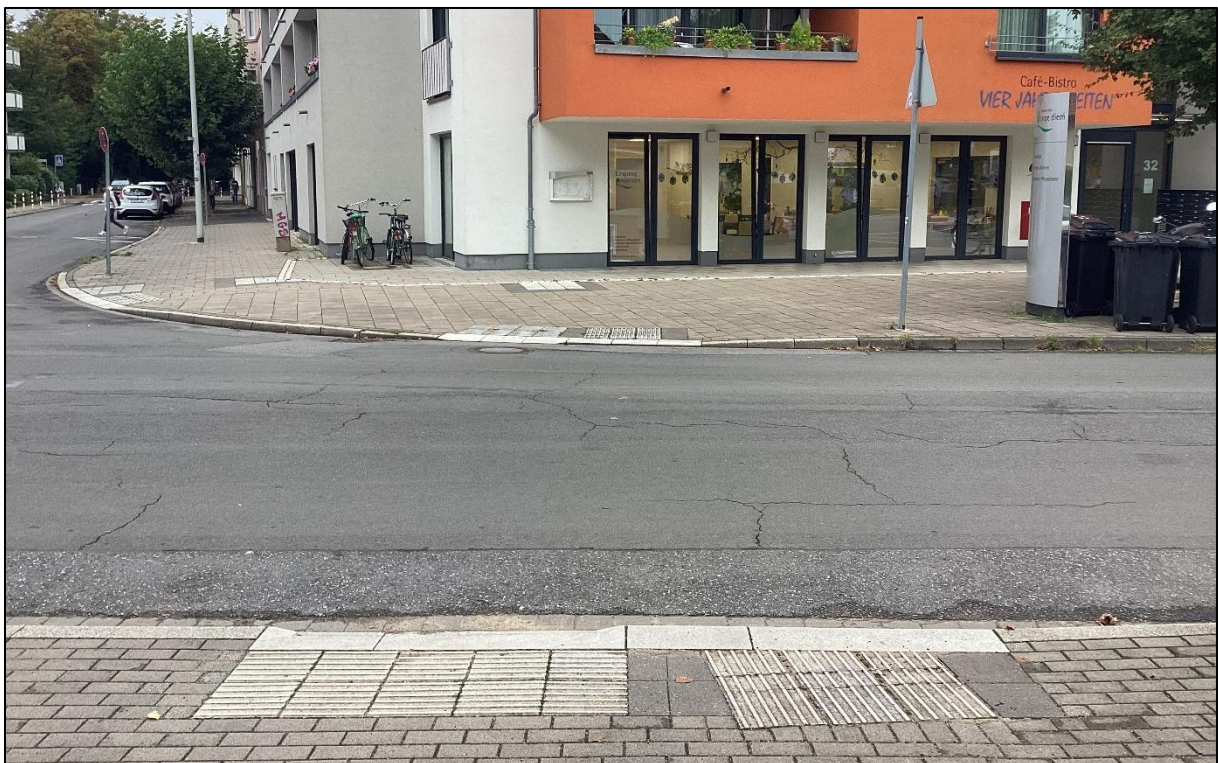
Abbildung 31: Querung mit taktilen Elementen über die Poststraße auf Höhe der Hausnummer 36-41; Quelle: eigene Aufnahme
