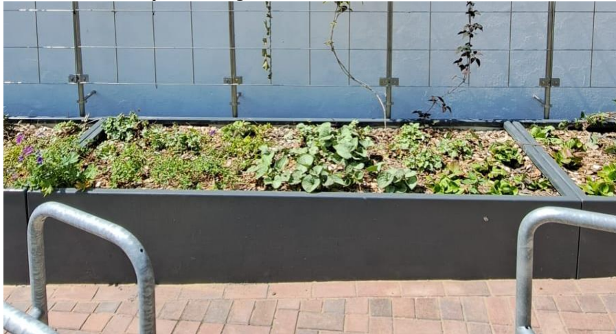
Pflanzbehälter Fassadenbegrünung Bürgerhaus
