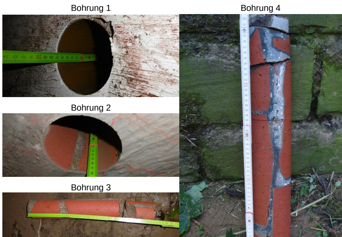
Abbildung 10: Bilder der Kernbohrungen
