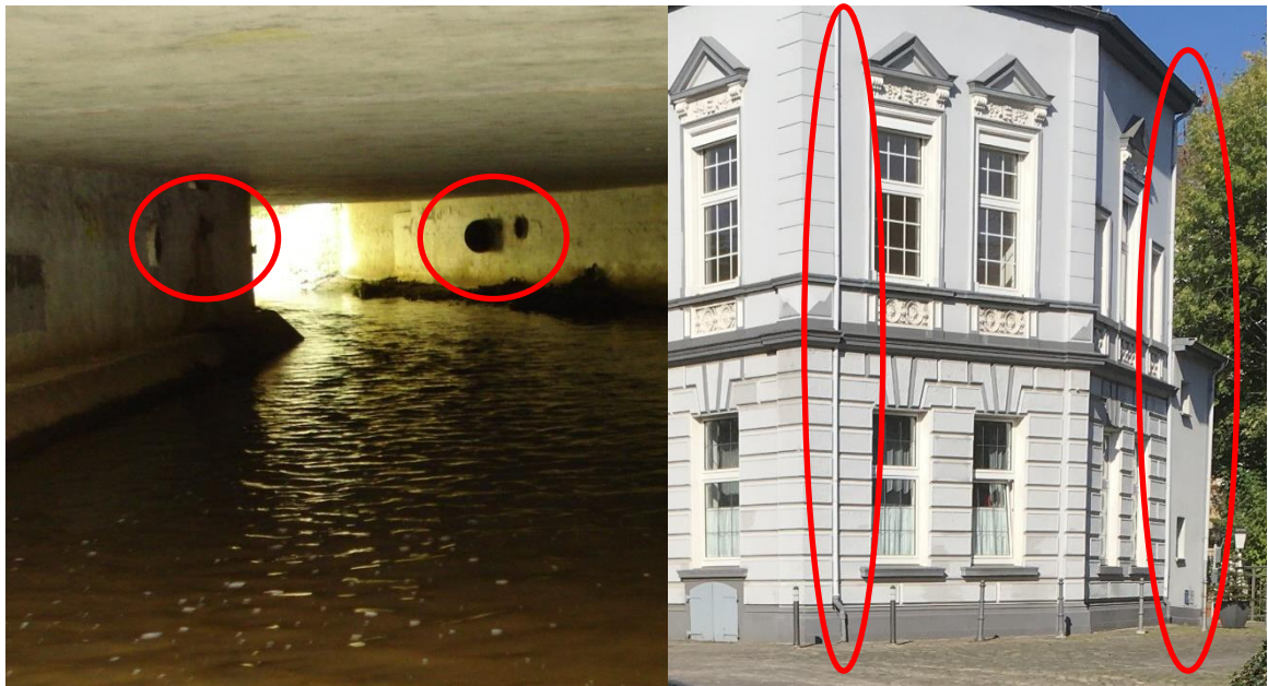
Abbildung 7: Einleitstellen im Bereich der Brücke
