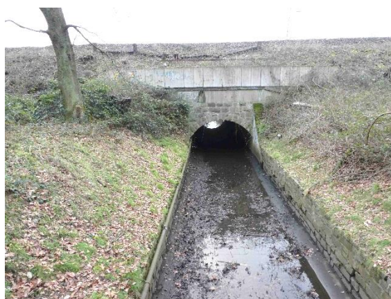
Foto 28: weitere Bahntrasse 20 m Meter entfernt (in Nutzung)
