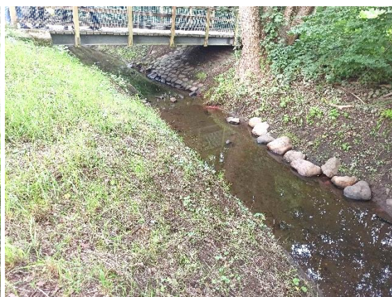
Foto 22: Brücke nahe der künftigen Einleitungsstelle
