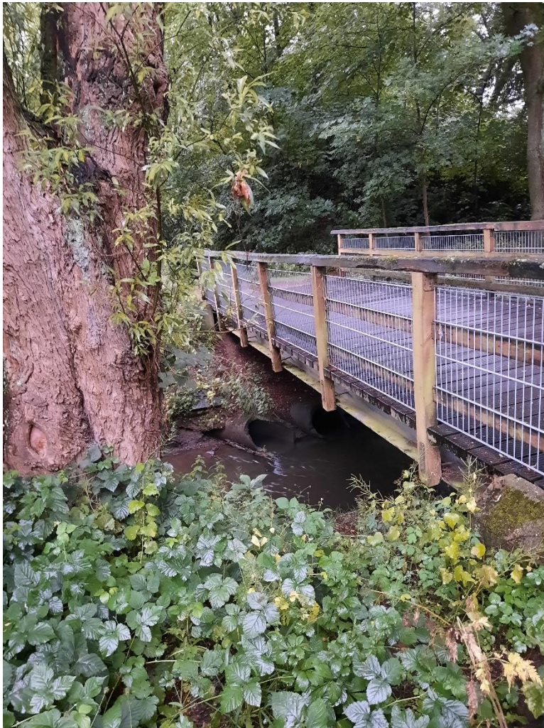
Bild 2 Aktuelle Einleitung DE-02-H
