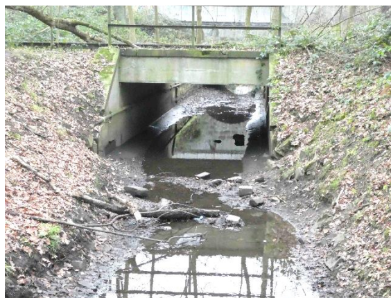
Foto 26: weitere Brücke (ehem. Gleisanlage) westlich im Wald; Bachprofil ab da aus Beton und stark begradigt
