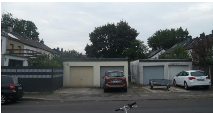
Mistweg: Einmündung zwischen den Garagen an der Querspange Gerhart-Hauptmann-Hof, Foto: Stadt Hilden
