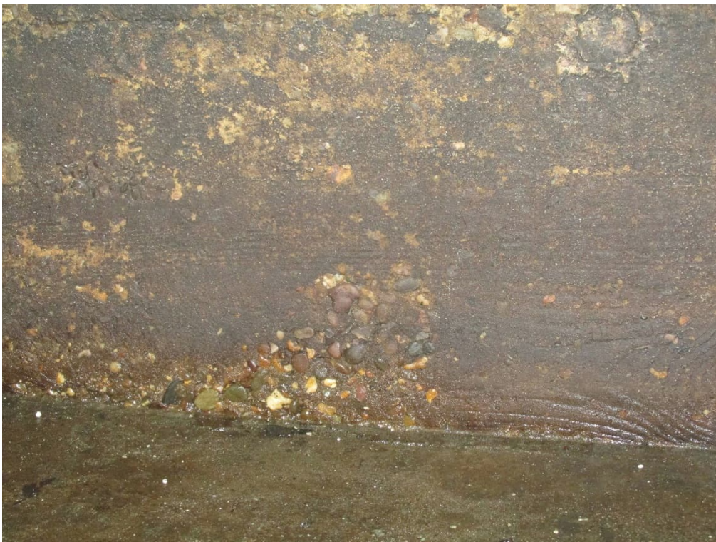
Abb. 5.22: Umlaufende Waschbetonstruktur auf ca. 40 cm Höhe an den Wänden
