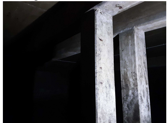
024 BETONABLATZUNG STÜTZE FREILIEGENDER BEWEHRUNG ACHSE 5
