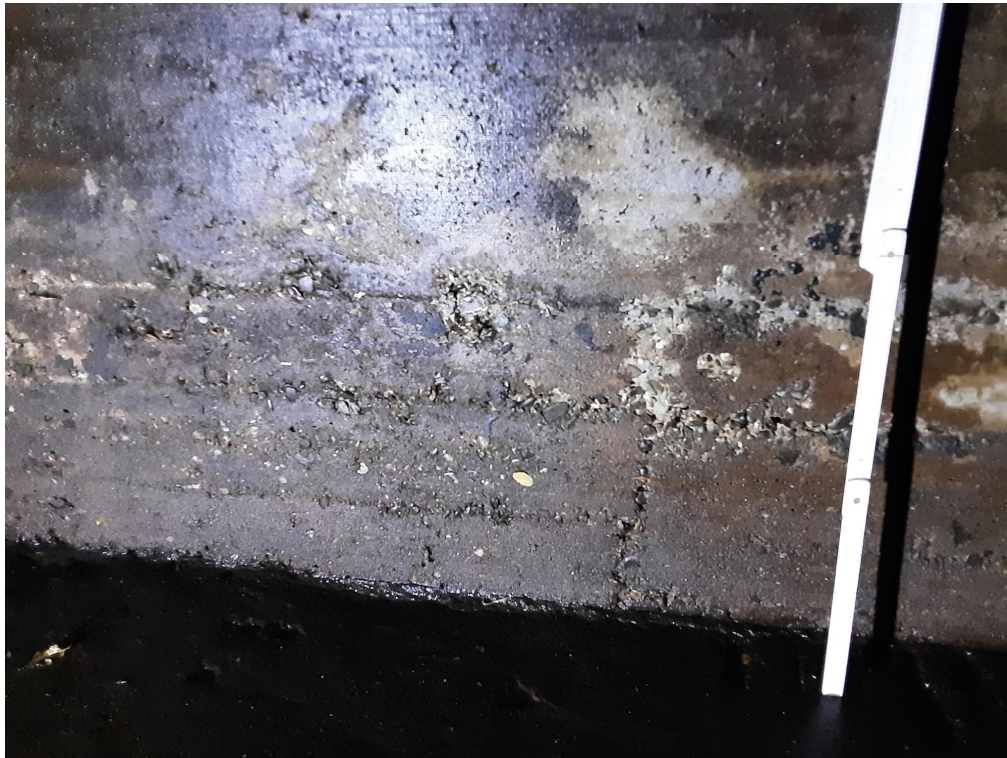
Abb. 5.2: Umlaufende Waschbetonstruktur auf ca. 40 cm Höhe an den Wänden
