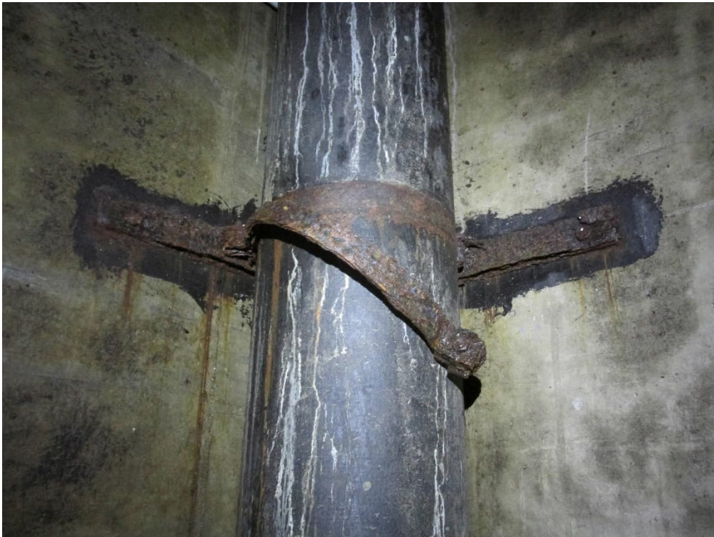
Abb. 5.19: Rohrbefestigung korrodiert
