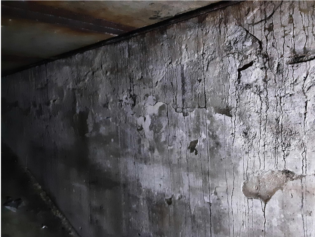
Abb. 5.12: Fehlerhafte Instandsetzungsmaßnahme
