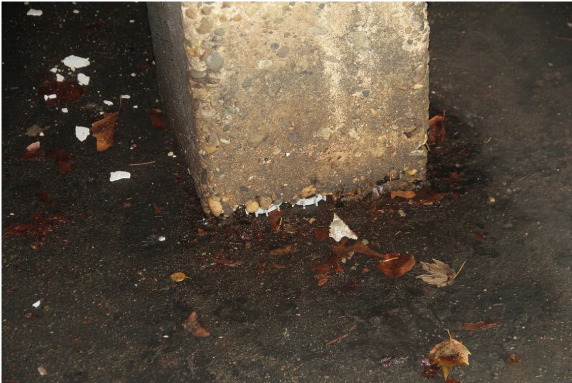
Abb. 5.4: Fehlende Betondeckung
