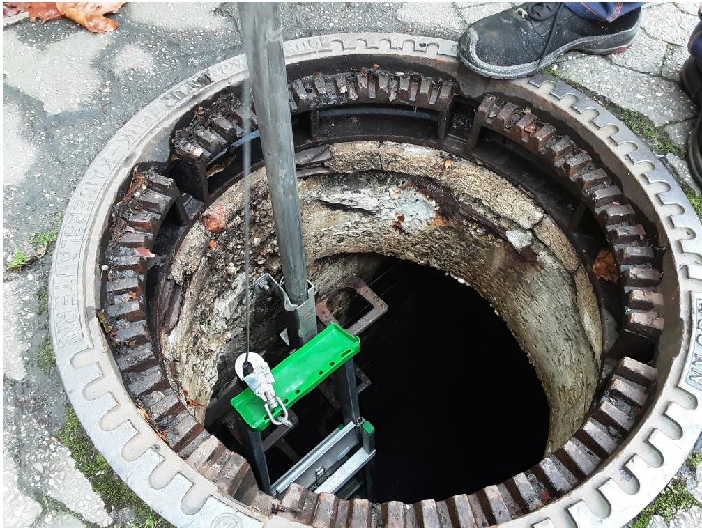
Abb. 5.10: Schachteinstieg korrodiert
