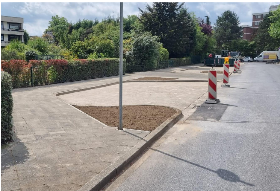
Ansicht nach Fertigstellung der Sanierung Johann-Strauss-Weg
