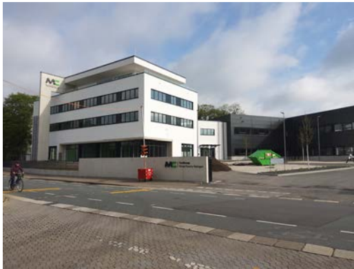
neu gestaltetes Betriebsgrundstück Bereich Rehhecke
