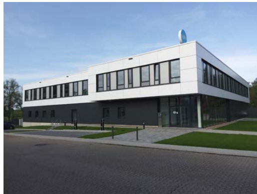
Betriebsfläche im südlichen Teilbereich
