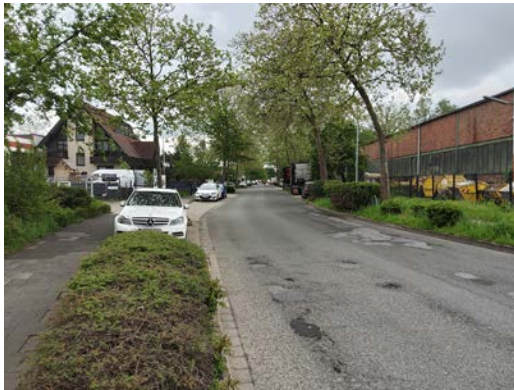
öffentlicher Raum mit teilweise abgenutzter Infrastruktur
