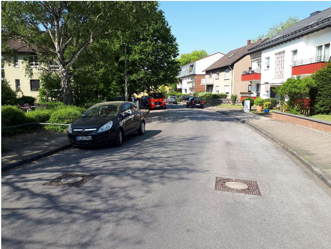
Abb. 3.5: Leibnizstraße, Blickrichtung Westen (Hegelstraße)
