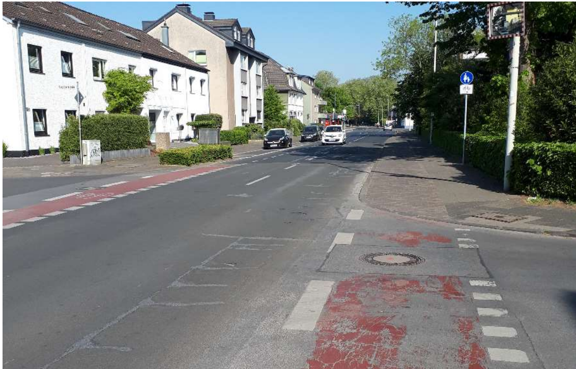
Abb. 3.1: RW-Schacht, Kreuzung Lindenstraße/Kantstraße, Blickrichtung Baustraße
