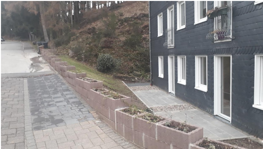
Abb. 5-2: "Pflanzmauern" zur Lenkung von Oberflächenabfluss (Beispiel)
