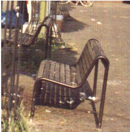
Für Poller, Fahrradständer etc. gilt ähnliches. So wird bei einer der vorgeschlagenen Produktreihen mit massiven rechteckigen Stahlprofilen gearbeitet. Auch hier ist eine hohe Dauerhaftigkeit gewährleistet.
