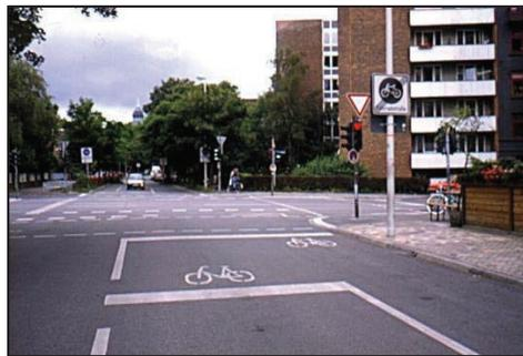
Bild 3-4: Fahrradstraßenzug mit Unterbrechung durch signalisierten Knotenpunkt mit aufgeweiteten Radaufstellstreifen (Kiel)
