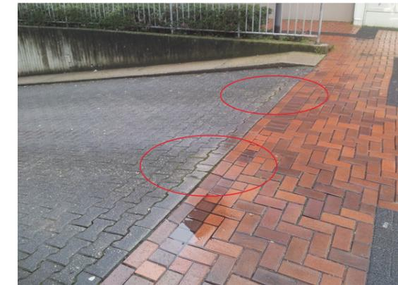
Am oberen Rampenansatz zur Tiefgarage setzen besonders tiefliegende Autos derzeit auf. Der 4 m breite Bereich vor der Rampe ist ebenfalls im Privatbesitz, ist aber in die öffentliche Fläche integriert. Die Tiefgaragenrampe selber kann als Betonkonstruktion nicht verändert werden.
