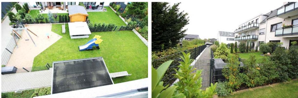
Abb. 3-4: Beispielhafte Begrünung der Tiefgaragendecke
