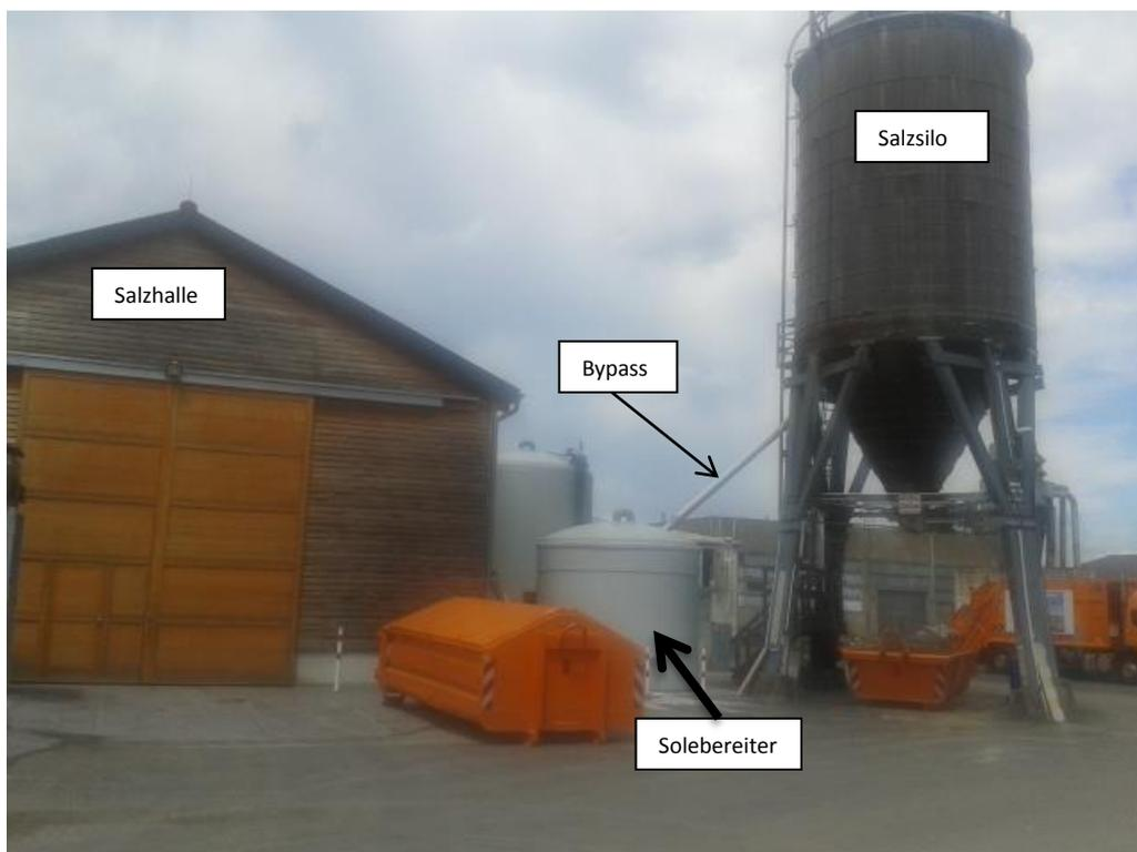
In Hilden wird grundsätzlich Feuchtsalz gestreut. D.h., bei Ausbringung des Streusalzes über den hinten am Streuer angebrachten Drehteller wird in einem Anteil von 30 % dem Streusalz Sole beigemischt. Das dadurch angefeuchtete Streusalz bleibt besser auf der Fahrbahn haften, so dass mit wesentlich geringeren Salzmengen gestreut werden kann.
