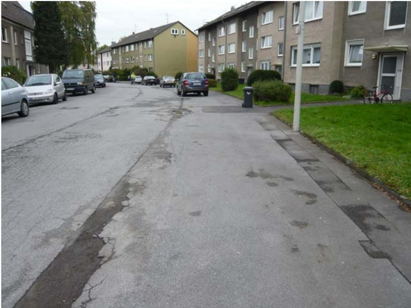
Abb.1: Straßenschäden und asphaltierter Gehweg
