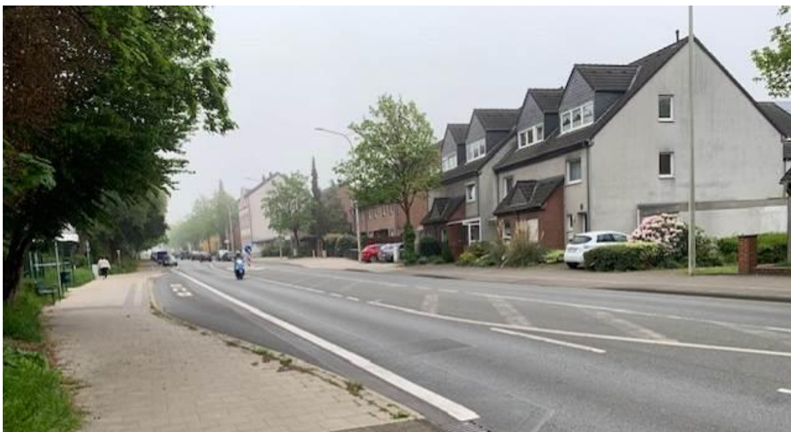
Blick stadtauswärts auf die gegenüberliegende Bebauung an der Walder Straße
