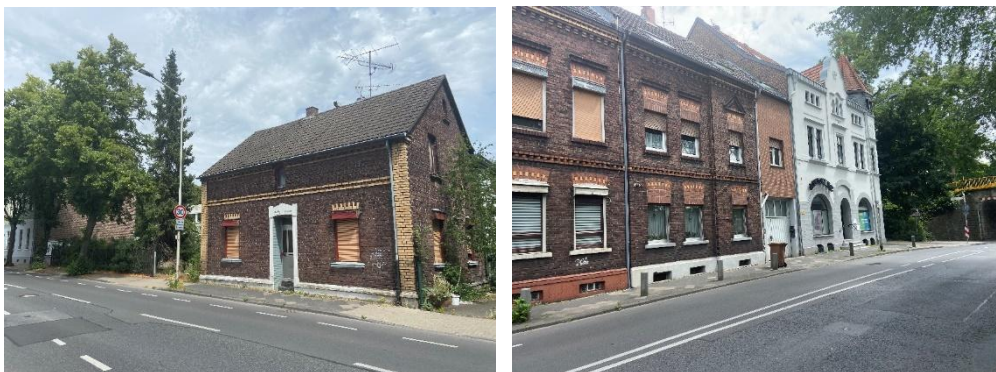
Abb. 2: Straßenseitiger Blick auf die Bestandshäuser Kirchhofstraße Hs.-Nr. 67 (links) und Hs.-Nr. 69 bis 73 (rechts); Quelle: büro stadtVerkehr
