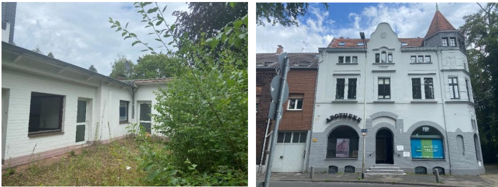
Abb. 3: Rückwärtige Gebäude Flurstück 647 (links), sowie das denkmalgeschützte Haus Kirchhofstraße Nr. 73 (rechts); Quelle: büro stadtVerkehr
