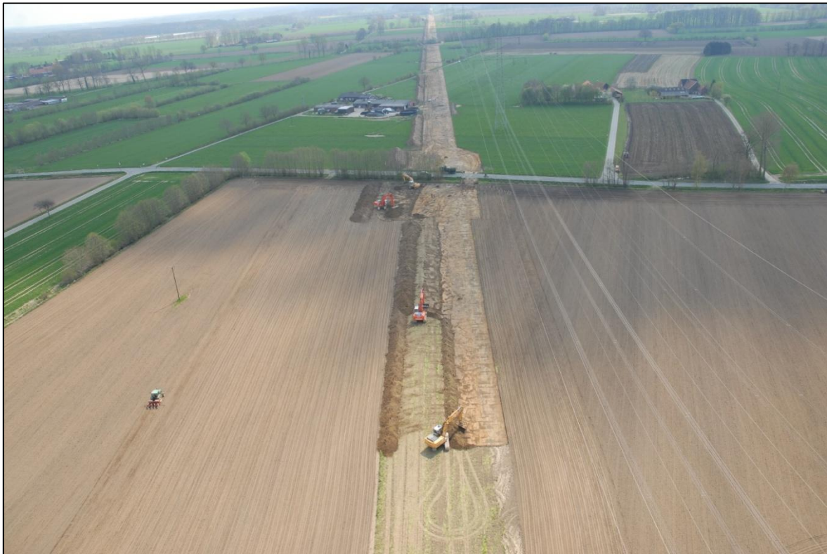
Abb. 3-4: Anlage eines Arbeitsstreifens (Quelle: OGE)
