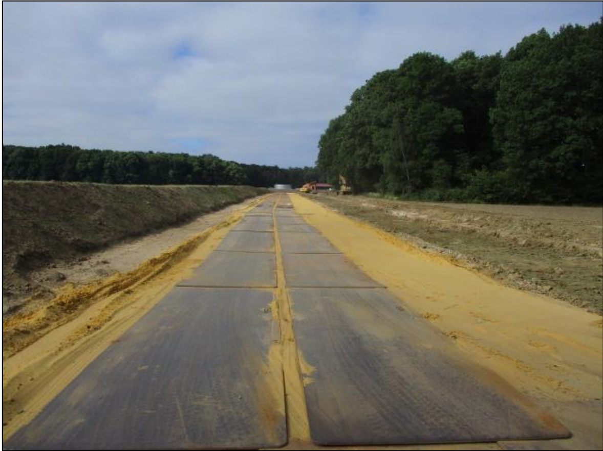
Abb. 3-5: Arbeitsstreifen mit Baustraße aus Stahlplatten auf Sandunterbau (Quelle: uventus)
