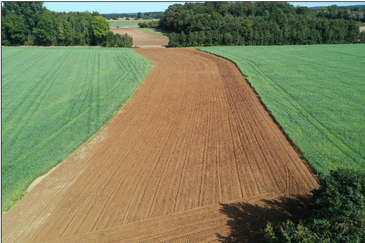
Abb. 3-10: Mit Mutterboden angedeckter und gelockerter Arbeitsstreifen (Quelle: OGE)
