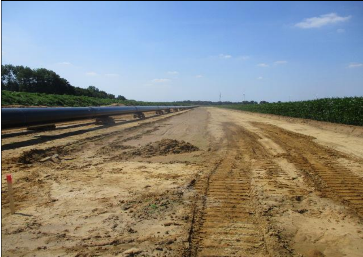
Abb. 3-7: Vormontierter Leitungsstrang (Quelle: OGE)
