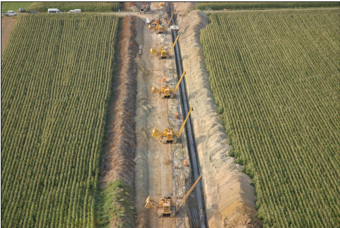
Abb. 3-8: Absenken des Rohrstrangs (Quelle: OGE)
