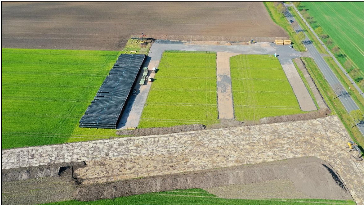
Abb. 3-6: Rohrlagerplatz (Quelle: OGE)
