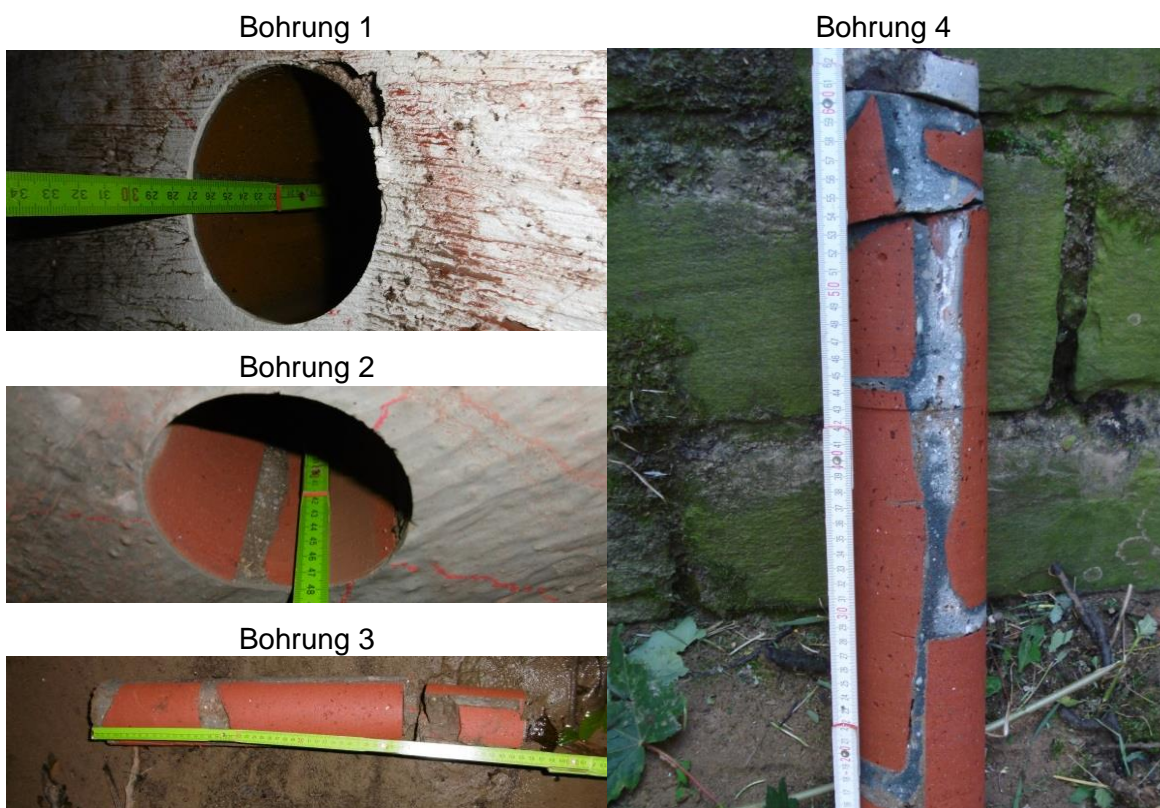
Abbildung 10: Bilder der Kernbohrungen
