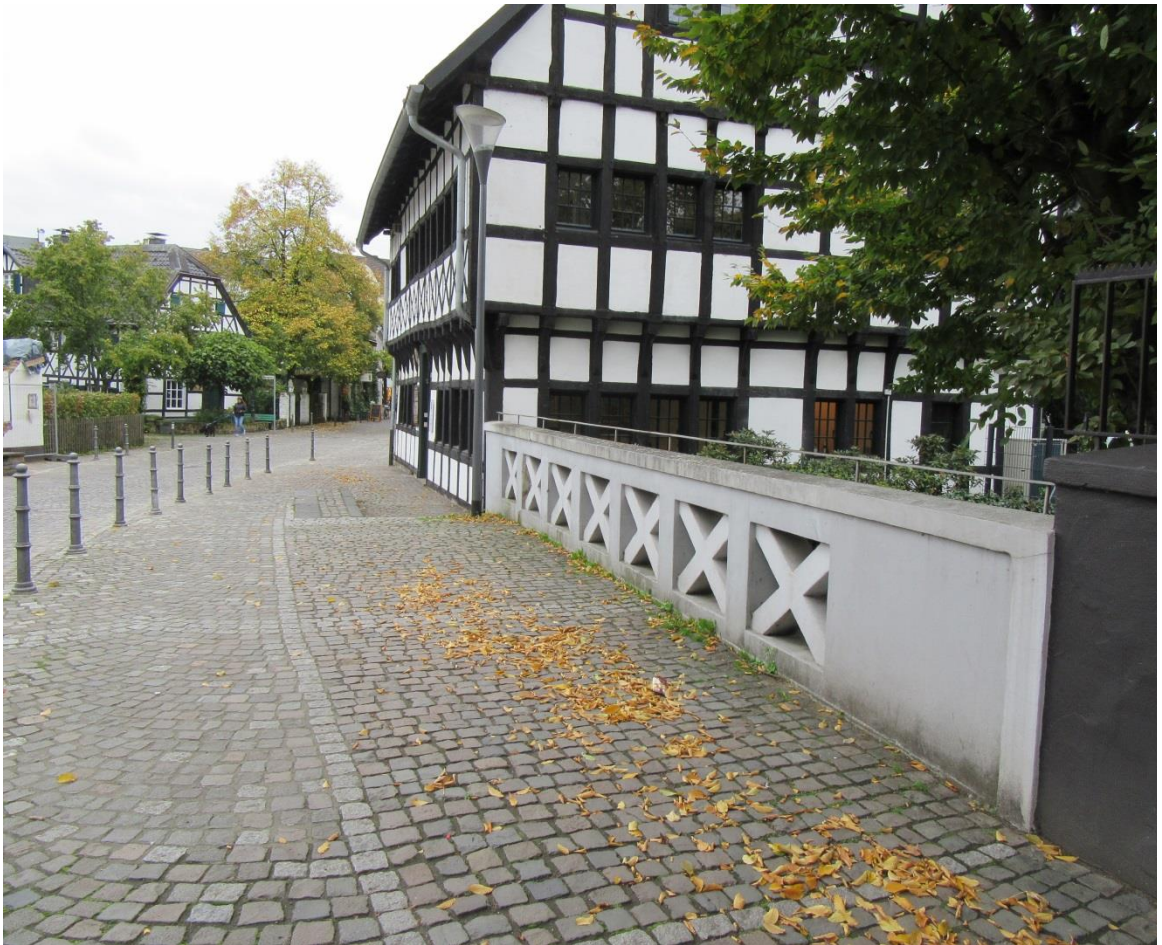
Abbildung 8: Geländer Westseite bestehende Brücke (vor Ausbildung des barrierefreien Streifens)
