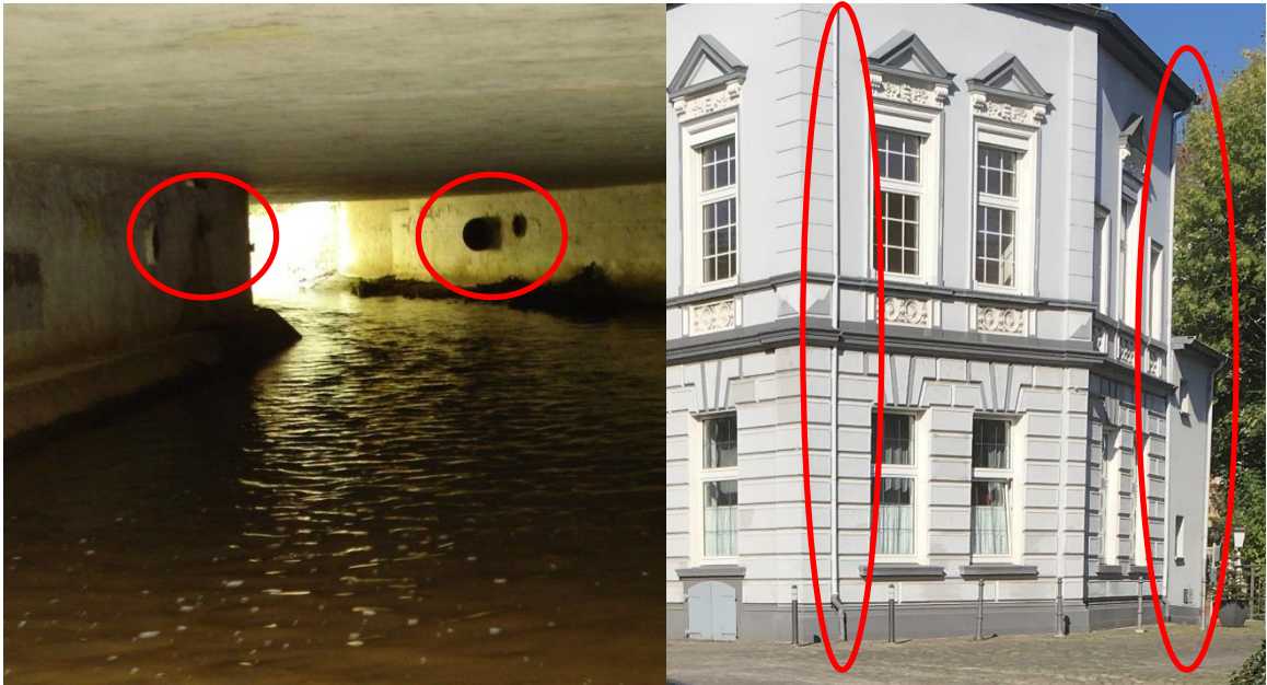
Abbildung 7: Einleitstellen im Bereich der Brücke
