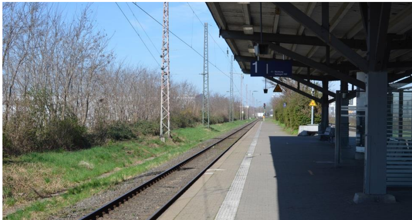
Abb. 2.5.4-2 Bahnhof Hilden mit alter Bedachung (eigene Aufnahme)
