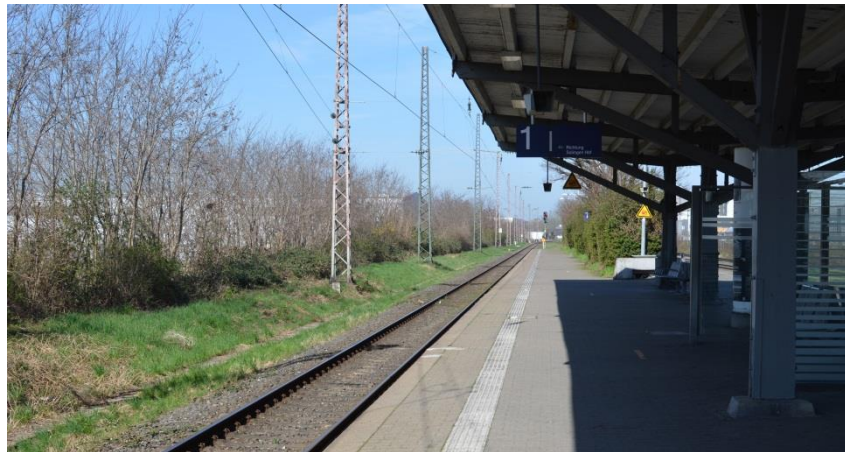
Abb. 2.5.4-2 Bahnhof Hilden mit alter Bedachung (eigene Aufnahme)
