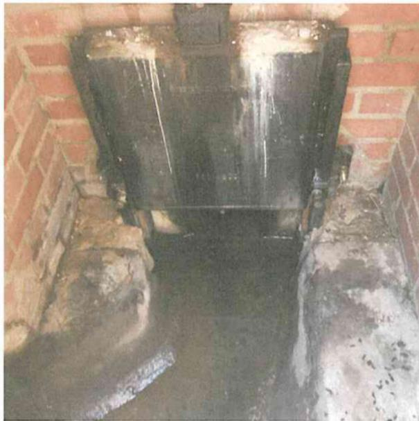
Bild 1 Schieber im Drosselschacht R5162
