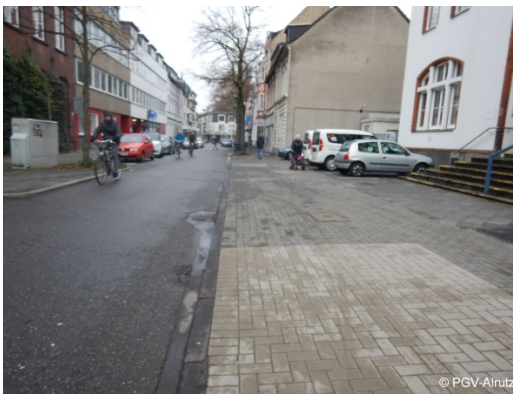
Abb. 4-38: Schulstraße, Blickrichtung Norden
