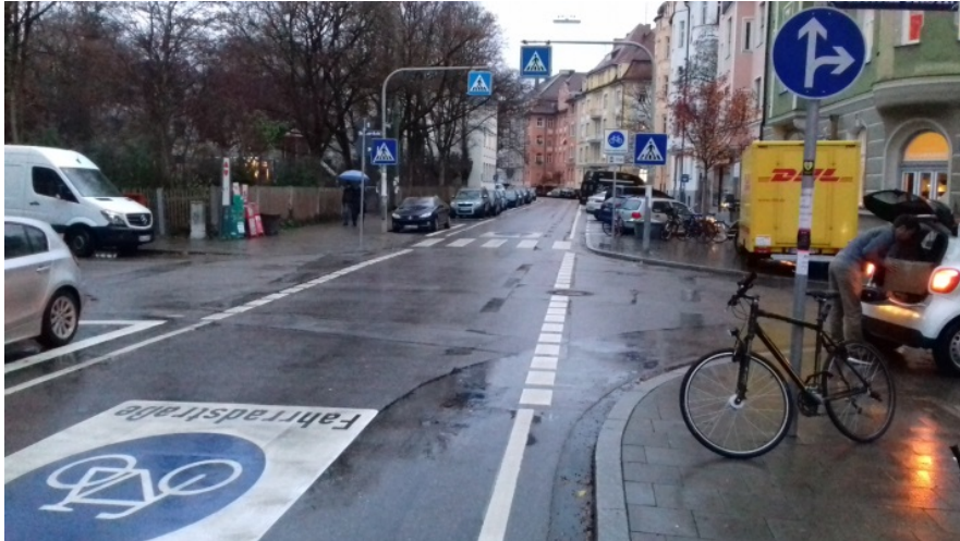
Abb. 2-7: Gestaltung einer Fahrradstraße mit Markierung, ähnlich dem für Hilden vorgeschlagenen Standard: Schmalstrich, Radverkehrsfurten an Nebenstraßen, großes Piktogramm Fahrradstraße. Abweichend von Hilden werden hier Parkstreifen mit Breitstrich markiert. (München)
