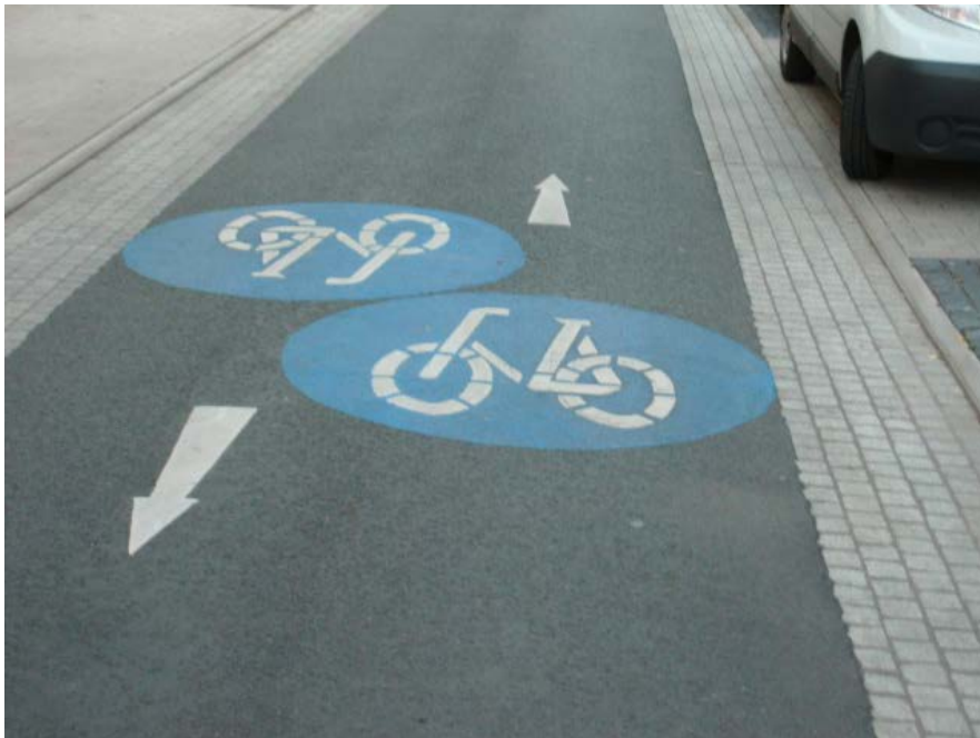
Abb. 2-8: Gestaltung einer Fahrradstraße nach Umbau: breite Rinnen zu beparkten Flächen als Sicherheitstrennstreifen (Hannover)
