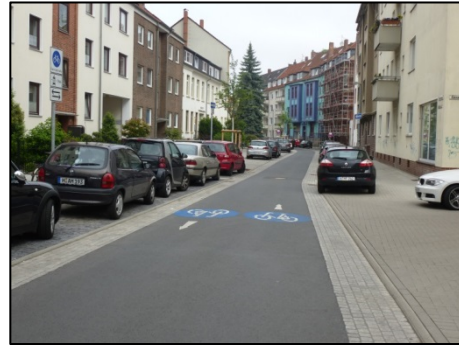
Abb. 2-3: Komplett umgebaute Fahrradstraße (Hannover)
