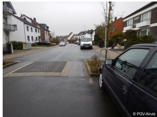
Abb. 4-26: Am Jägersteig, Blickrichtung Westen
